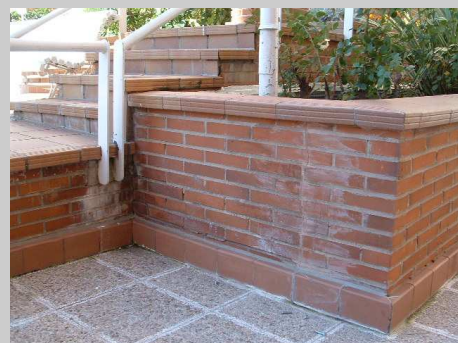
Fotos de grietas debido al asiento diferencial de la crujía en muros exteriores y terraza
